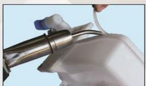
کاربرد الکتروود جوشکاری نوع PE معمولاً در تانکرهای آب (سفید رنگ) و تانکرهای سوخت (مشکی رنگ) می‌باشد. هنگام کار روی محصولات آسیب دیده، ابتدا باید دمای جوشکاری را بسته به ضخامت قطعه آسیب دیده تنظیم کنیم. سپس در محل مورد نظر برای تعمیر، یک شیار ایجاد کرده و یک لایه جوش با الکتروود نازک روی آن انجام می‌شود؛ سپس پلیسه یا زائده‌های اطراف گرفته شده و یک لایه از الکتروود ضخیم روی کار نهایی جوش می‌خورد.
